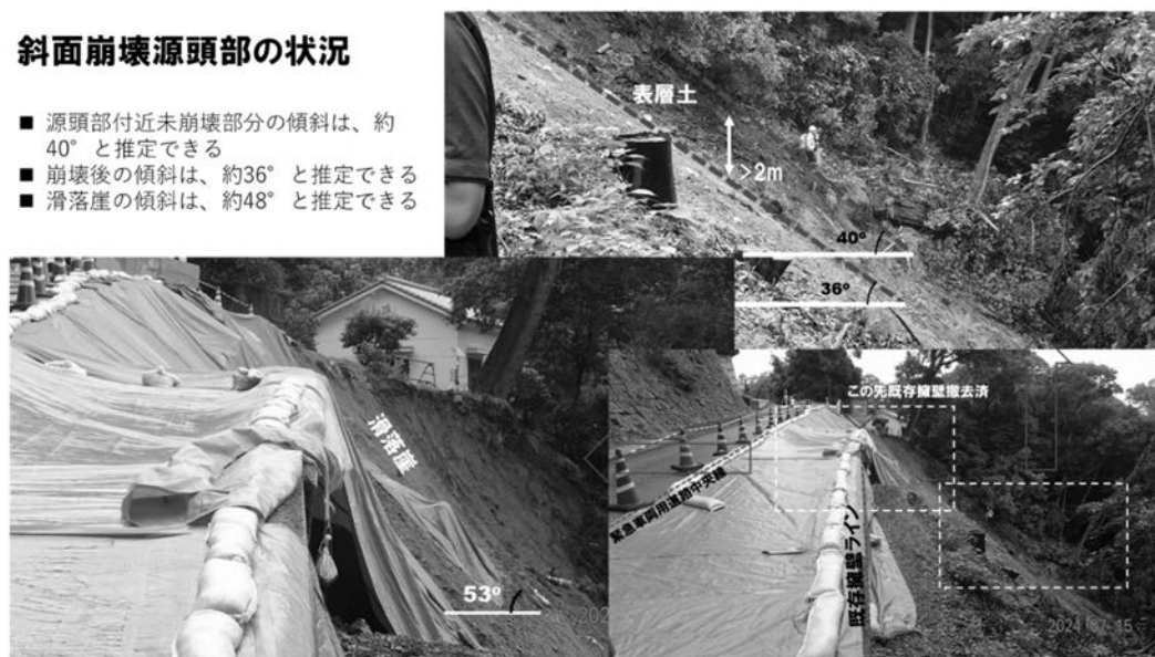
図-2：斜面崩壊地源頭部の状況（7月15日）
