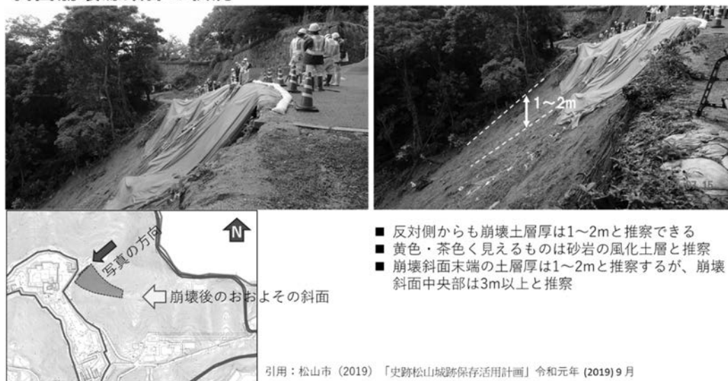
図-1：斜面崩壊の位置図および源頭部の状況（7月15日）
