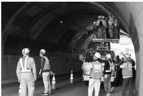
トンネル（砥鹿山隧道）
