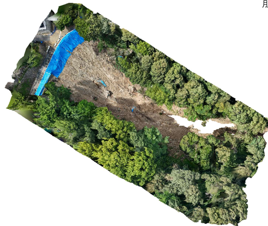
崩壊斜面のドローンオルソ画像
