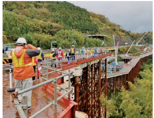
CTB-ehime 見学会 ～高速道路4車線化、 河川防災工事と建設ICT 施工～ (令和4年11月29日～30日)
