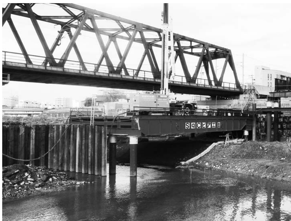
ロングスパン・Sqc ピア・長尺橋梁工法による仮設工事例
