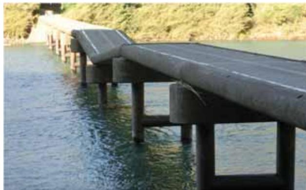
写真 1 沈下橋の損傷状況
