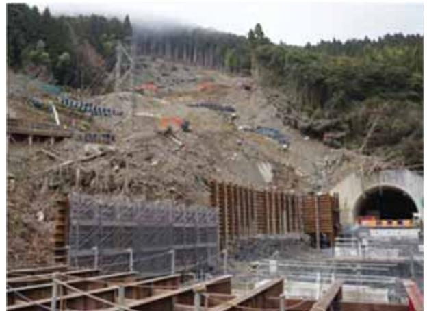
写真-10 仮設落石防止柵設置状況
