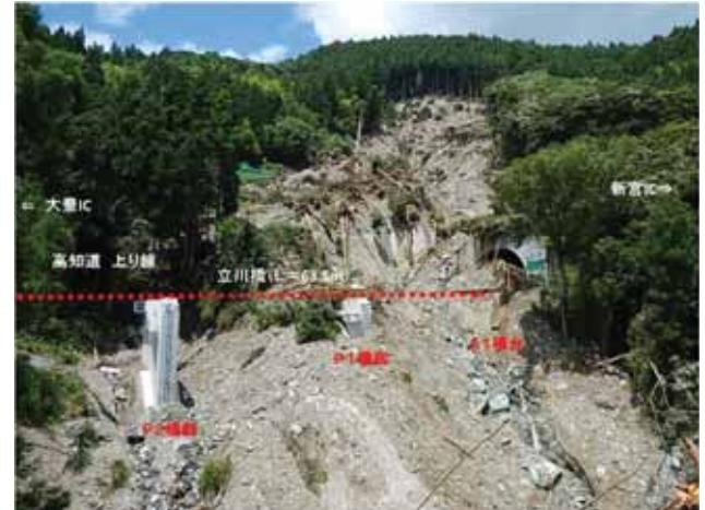
写真-2 立川橋 (上り線) 流出写真
