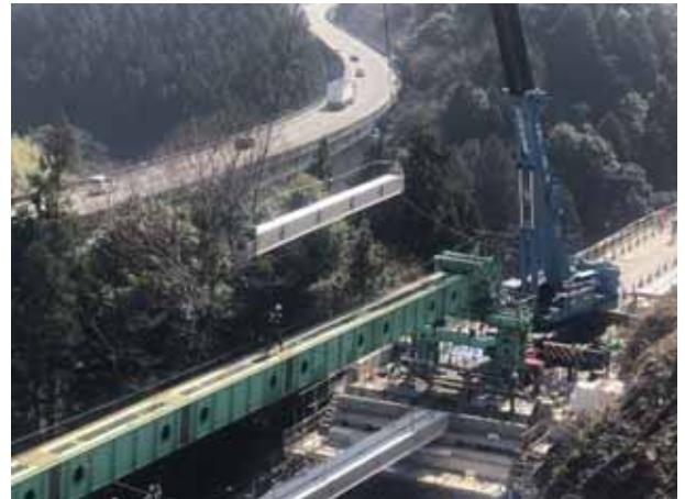
写真-8 架設桁による上部工架設状況写
