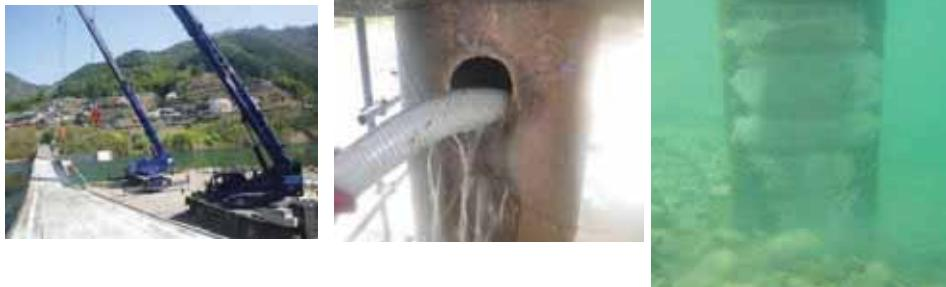
断面欠損部はグラウトを注入し応急対策
