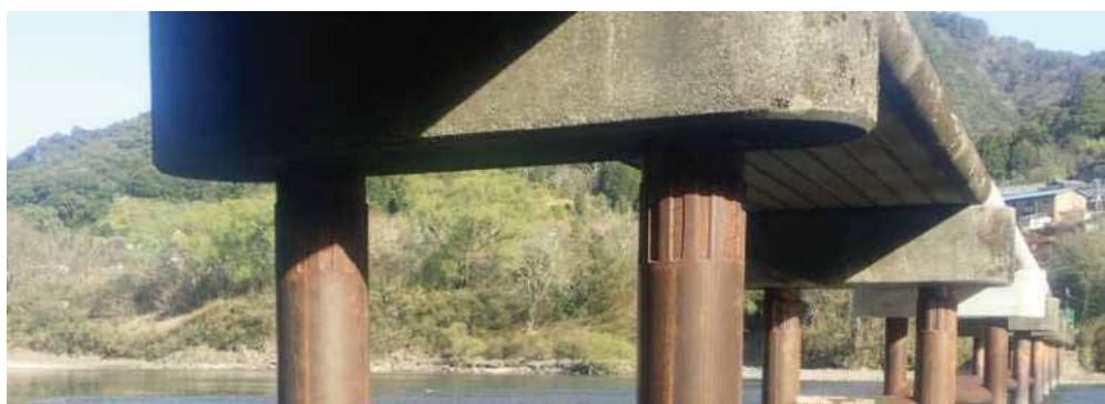
写真4 当て板補修後の定着部の状況
