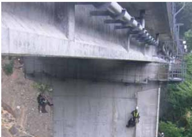
写真-5 ロープアクセスによる近接目視点検
