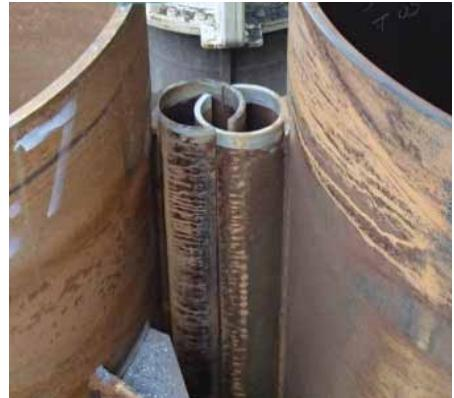
写真-2 継手構造
