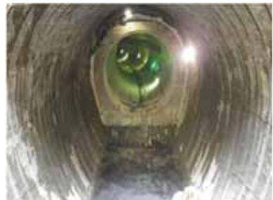
写真-7 底版部掘削完了
