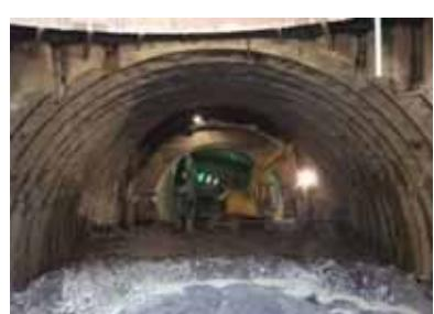
写真-6 上半部掘削完了
