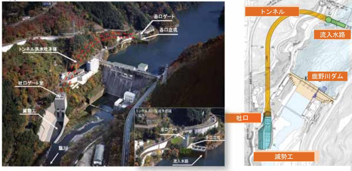
図-3 トンネル洪水吐 配置図
