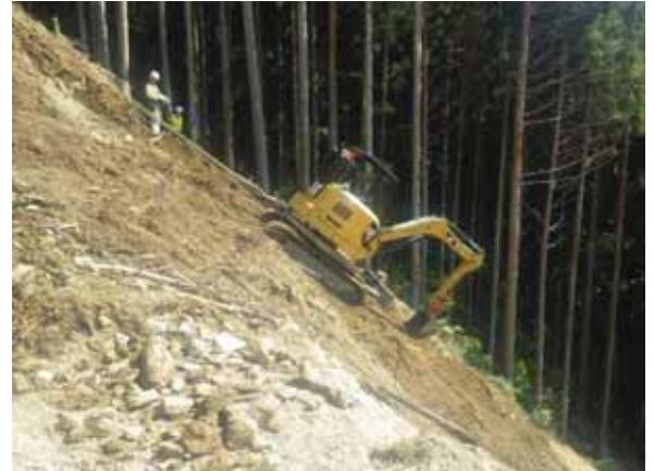
写真-7 無人バックホウによる施工状況
