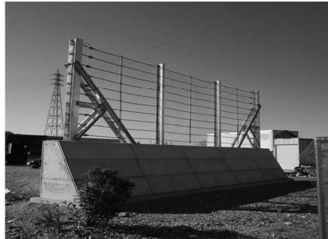
補強鉄筋と中詰めコンクリートを打設して完成
