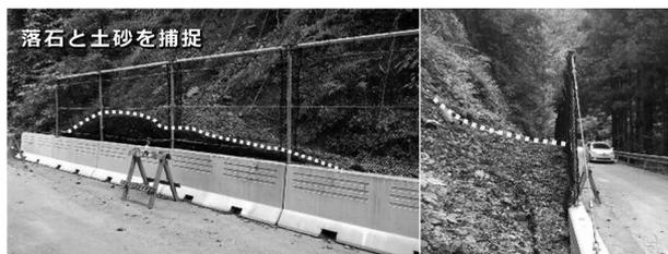
写真-4 落石交じり土砂を捕捉
