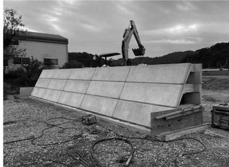
3段目のプレキャスト型枠設置状況(斜め前)
