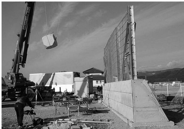
多面体重錘とRsウォール工法による擁壁
