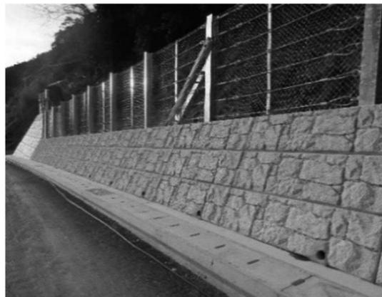
写真6 Rsウォール工法による一般国道494号の落石防護擁壁
