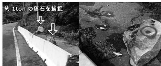
写真-5 1tonクラスの落石を捕捉
