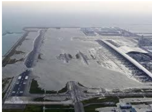
平成30年台風第21号による関 西国際空港の被害状況
