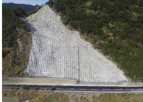
土砂災害等の危険性が高い約2000箇所の道路法面・盛土対策、道路拡幅等
