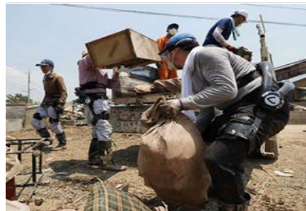
災害現場でロボットスーツを装着して土砂を運び出す （H30年7月15日 岡山県倉敷市真備町＝時事通信）
