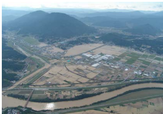
H16 台風第16号 肱川氾濫（大洲市）
