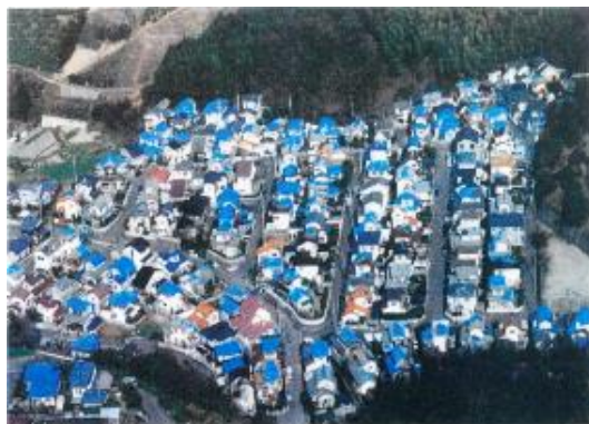
H13 芸予地震 ブルーシートで屋根を応急処置した住宅（松山市）
