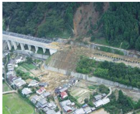
H16 台風第21号 がけ崩れ（新居浜市）
