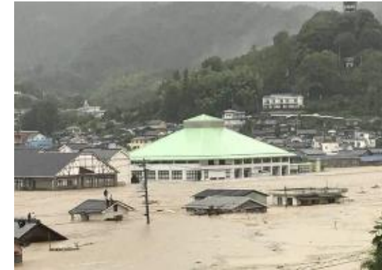
H30 西日本豪雨 肱川氾濫（西予市）
