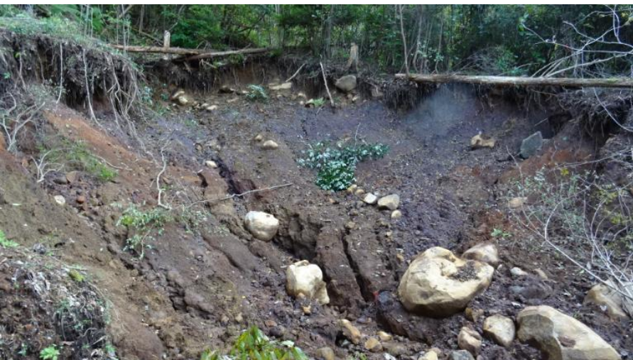
住宅背後斜面の崩壊，火山灰質土の中に玉石状の溶結凝灰岩の転石
