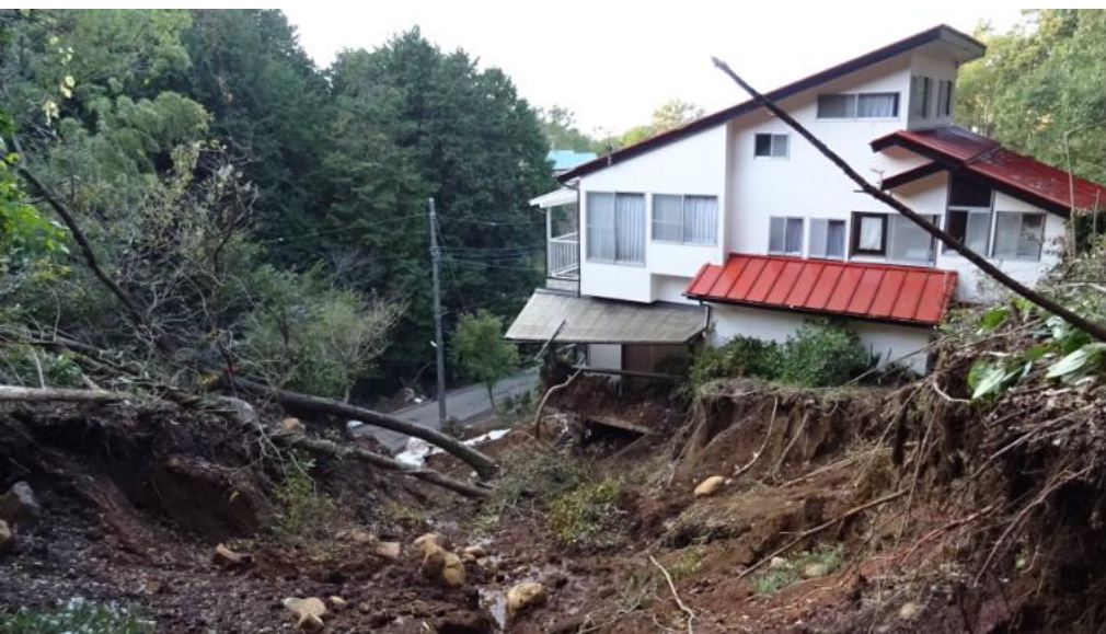
住宅背後地盤滑落崖には表層内の転石が見える
