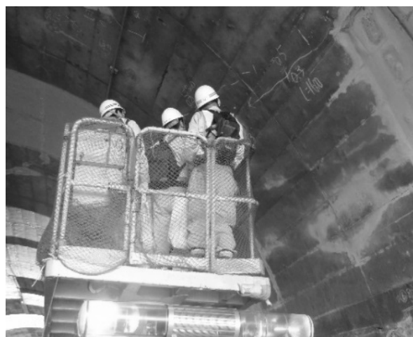
今治市 砥鹿山隧道高所作業車による点検
