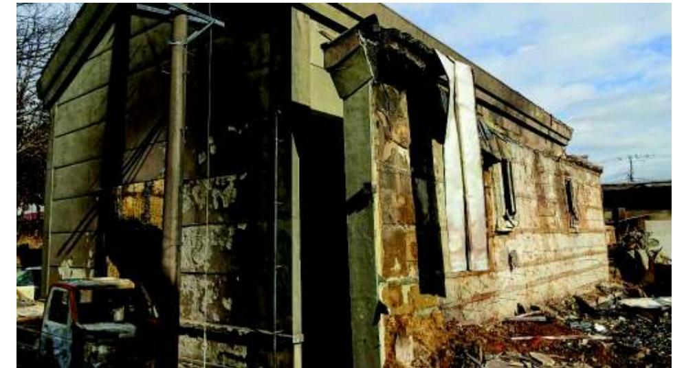
写真左は醸造タンクが見える。内側の壁表面が落し下し、柱部材の木の表面が炭化している。木造骨組みの土壁で外側はモルタル仕上げ。屋根軒は短く、2段の意匠。外壁にも横縞。
