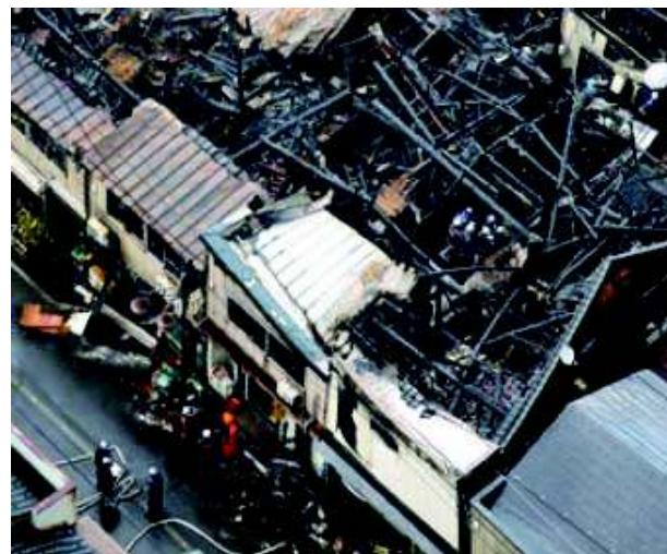
1階鉄骨フレームの上に木造2階。右奥厨房は壁が下から焦げる。正面奥と左の壁は上部から焦げる。1階テーブルの上に2階の焼け落ちが堆積。火は上にのみ拡大。
