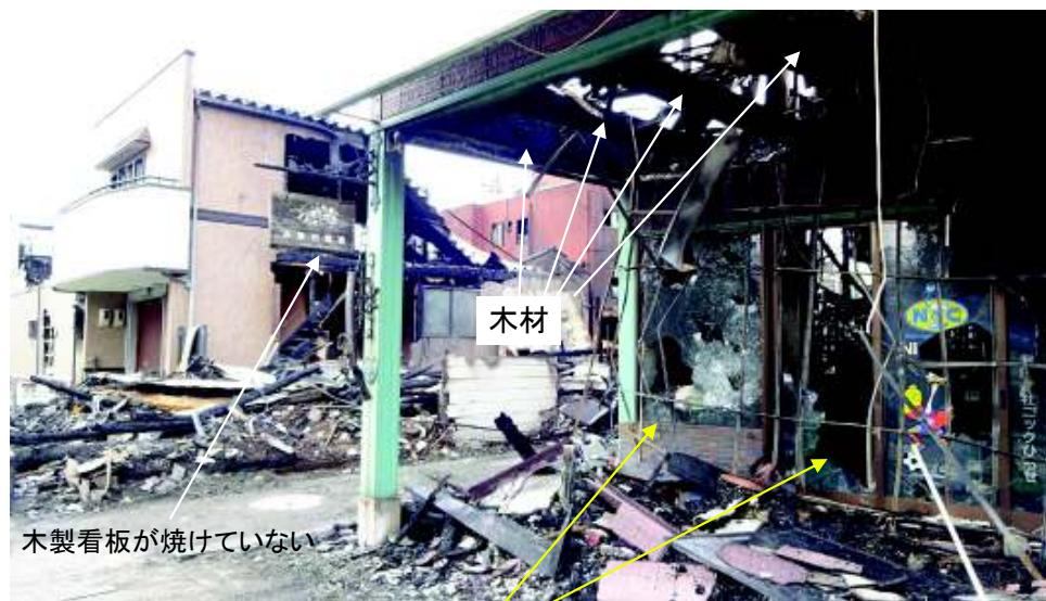
正面のワイヤー補強ガラスは消火注水のために割られていた(?)。2階床を支える木製梁は焼損し、床は焼失していた。外壁の耐火性能が高く、残っている。
