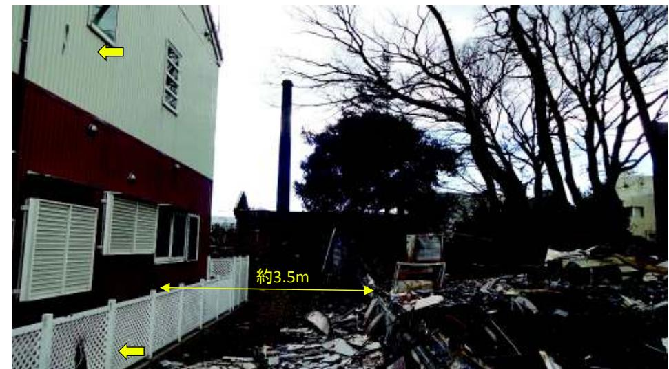
西側の住宅(全焼)とは約3.5mの離隔。2階外壁の2箇所に飛散した焼け木片の当たった痕跡を確認。樹脂製フェンスの一部が溶ける。それ以外は影響認められず。西側の住宅は、南側に空き地と樹木群。北側に道路とブロック塀。西側からの延焼。
