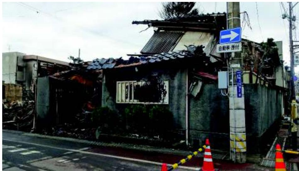
写真左は醸造タンクが見える。内側の壁表面が落し下し、柱部材の木の表面が炭化している。木造骨組みの土壁で外側はモルタル仕上げ。屋根軒は短く、2段の意匠。外壁にも横縞。
