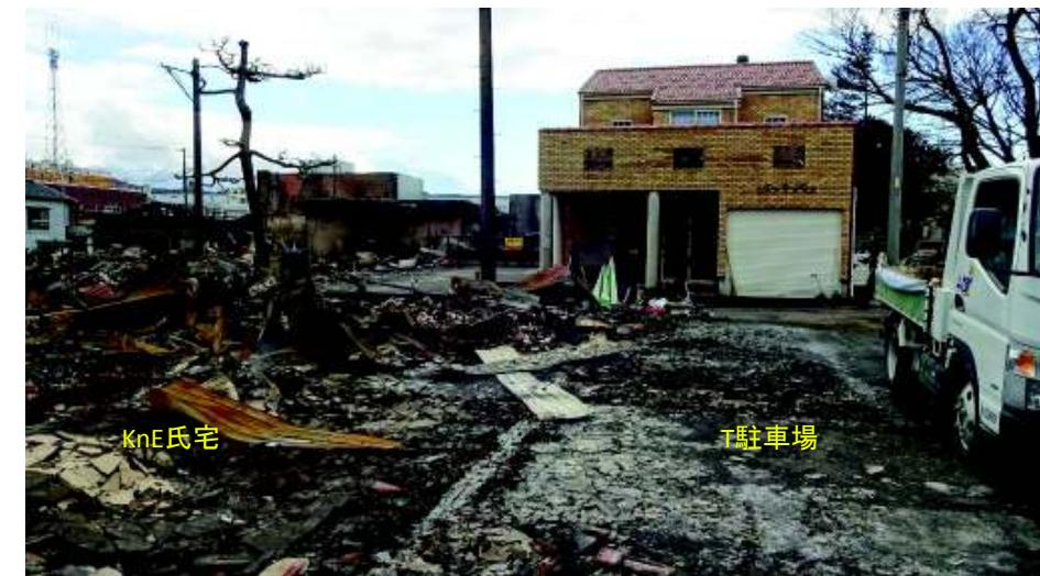
北側の住宅(KnE氏宅)は全焼したが、約3mの離隔。2階外壁の1箇所に飛散した焼け木片の当たった痕跡を確認。樹脂製フェンスの一部が溶ける。それ以外は影響認められず。西側の住宅は、南側に空き地と樹木群。西側もしくは北側からの延焼により焼損
