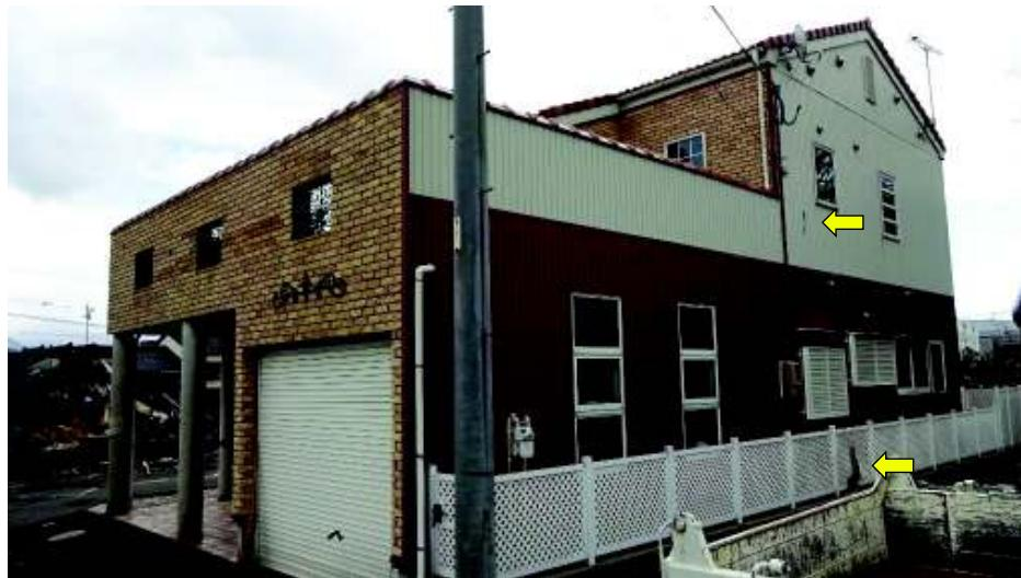
1階・2階の外壁は全て耐火素材。軒は出ておらず、瓦下にも隙間がない。換気口も金属製で開口が小さい。北側は1階・2階ともに防火タイル。
