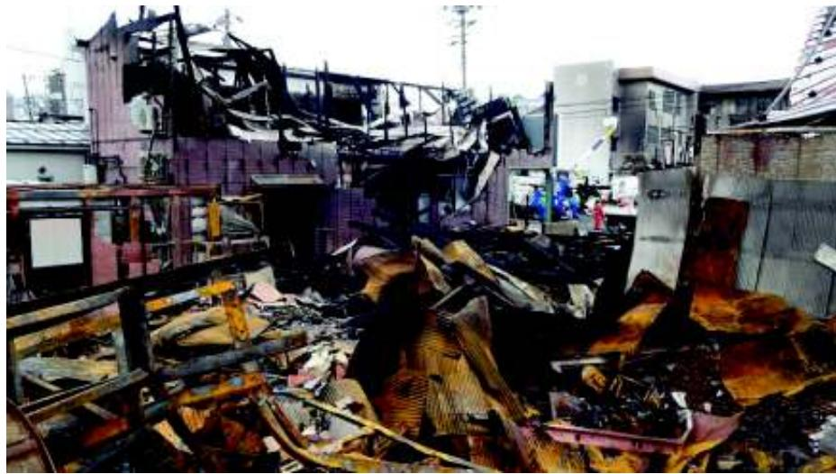
西側外壁にも窓より上部にしか類焼痕跡がない。→西側隣家の2階からの延焼、もしくは屋根に着火した可能性が高い。
