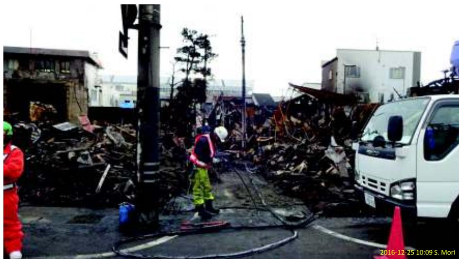
焼け落ちた電線を調査、復旧する様子。手前の電柱の基部にまいてあるカバーは焼けて溶けている。
