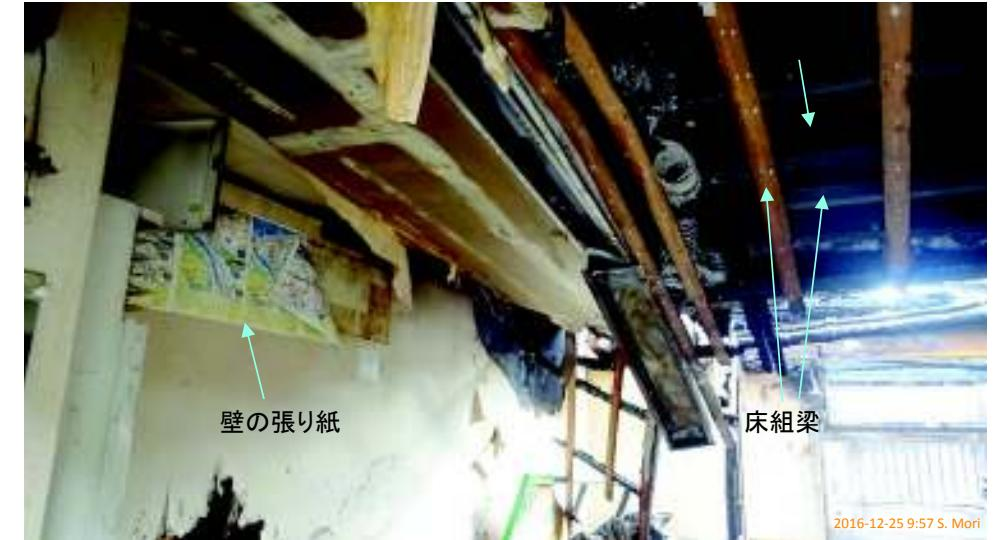
木造2階の床組格子梁は細く、上側梁は焼ける。その上に焼け落ちた柱が倒れている。左の壁は上部から焦げるが、下方には炎は回らず、壁の張り紙も燃えていない。張り紙の下方は隣の家から押されて開いた穴。
