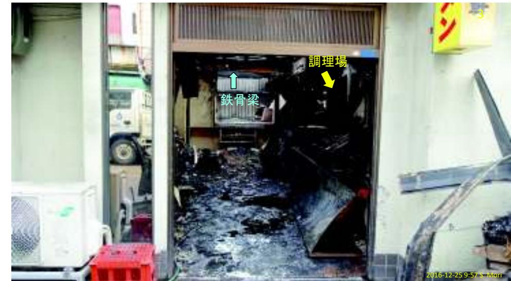
ラーメン店は5番目、北隣(風上側)の4番目の建物に延焼している。2階部分から類焼して、階下に延焼したようである。1階入り口ドアの内側が焼けている。ラーメン店の2階の南側屋根が落ちているのは、その下の柱が焼け落ちたためである。
