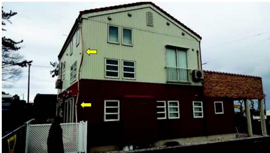
1階・2階の外壁は東・南側面、全て耐火素材。軒は出ておらず、瓦下にも隙間がない。換気口も金属製で開口が小さい。ベランダ側面は防火タイル。**南東側の雨樋に熱変形**が確認。それ以外は影響確認されず。壁面、ガラスなどの耐火性能が検証。
