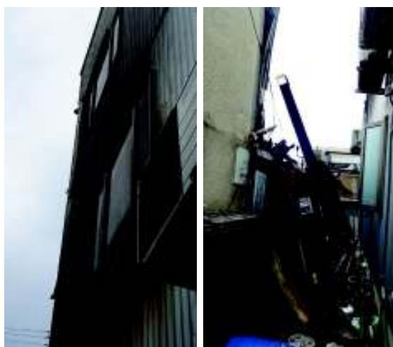
広小路通り沿い大町1丁目2番地の南西角より北方向に10番目となる3階建ていけばな教室建物は、通り側を除く3面から火炎から襲われていた。それにもかかわらず、外観だけから判断するに、通りの面に火災の影響を確認できなかった。外壁にすすぐが付いていたが、外壁も窓も内部に類焼させておらず、防火造の性能を発揮したように見えた。地道な防火改修が、予期せぬ大火に対しても有効であることを検証したように思われた。
