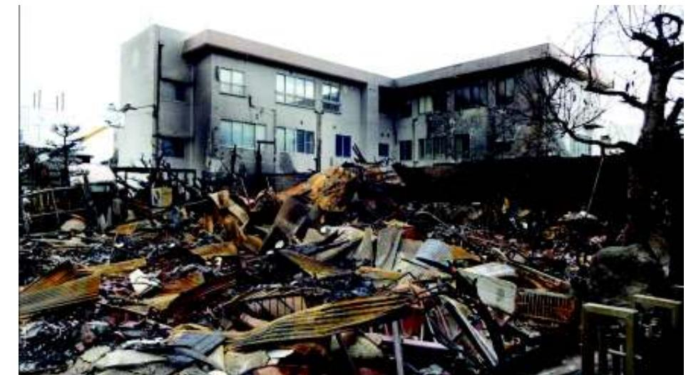
J.Aひすいの北西部の家屋は焼失。北側と西側に延びるL字型平面のJ.Aひすい建物の外壁には3階まで火炎が延びた痕跡が外壁に残る。
