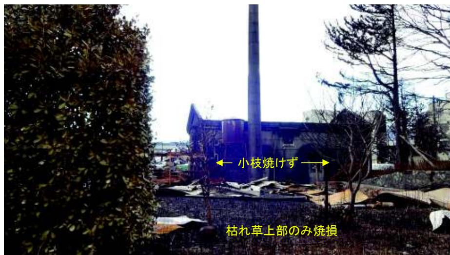
真南側は空き地(草と灌木、植木鉢のみ)。輻射熱による枯れ草が燃焼しているが、灌木の小枝は燃えていない。したがって、輻射熱は低いものと推察される。
