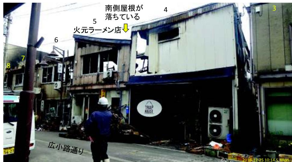
ラーメン店は5番目、北隣(風上側)に密接している4番目の建物に延焼した。2階部分から類焼して、階下に延焼したようである。隣の建物1階入りロードアの内側が焼けている。ラーメン店の2階の南側屋根が落ちているのは、その下の柱が焼け落ちたためである。
