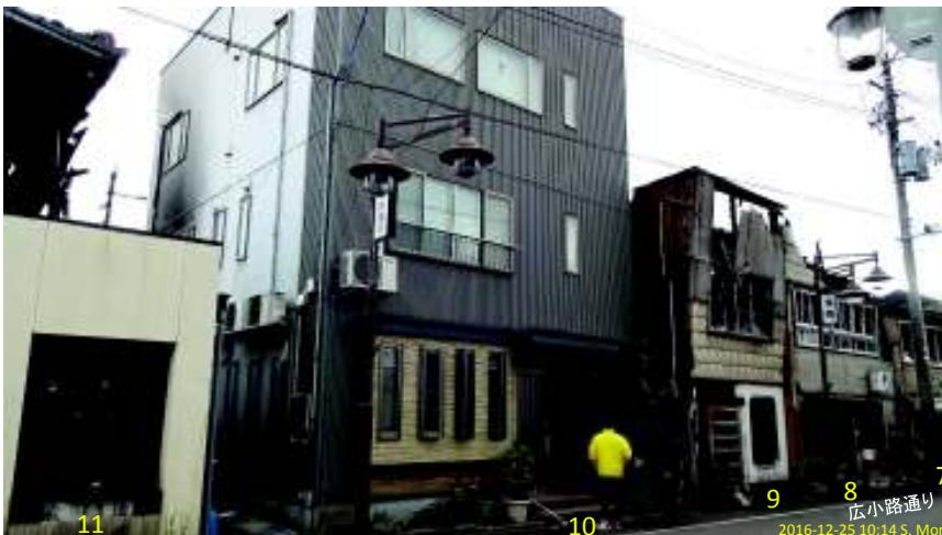
広小路通り沿い大町1丁目2番地の南西角より北方向に10番目となる3階建ていけばな教室建物は、通り側を除く3面から火炎から襲われていた。それにもかかわらず、外観だけから判断するに、通りの面に火災の影響を確認できなかった。外壁にすすぐが付いていたが、外壁も窓も内部に類焼させておらず、防火造の性能を発揮したように見えた。地道な防火改修が、予期せぬ大火に対しても有効であることを検証したように思われた。
