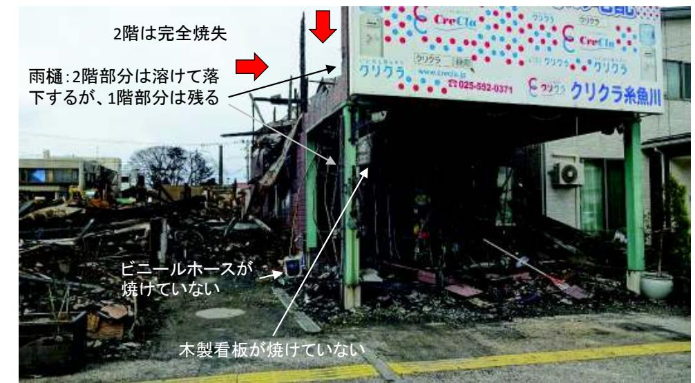
正面の看板や柱には延焼の痕跡がなく、西側外壁にも窓より上部にしか類焼痕跡がない。→西側隣家の2階からの延焼、もしくは屋根に着火した可能性が高い。
