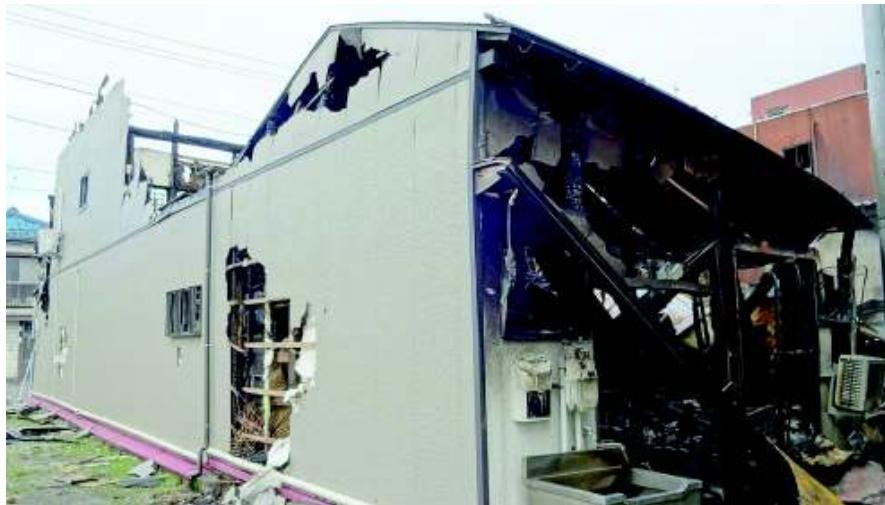
南側の壁損傷は、破壊消防の痕跡であろうか。
