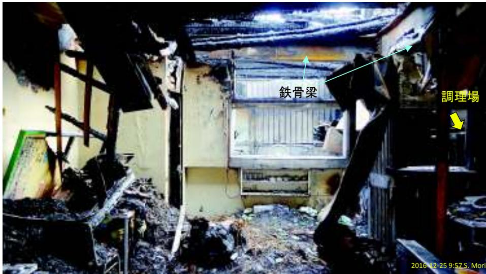
1階鉄骨フレームの上に木造2階。右奥厨房は壁が下から焦げる。正面奥と左の壁は上部から焦げるが、下方には炎は回らず。1階テーブルの上に2階の焼け落ちが堆積。すなわち、火は調理場で上にのみ拡大、2階床以上で四方に拡がる。
