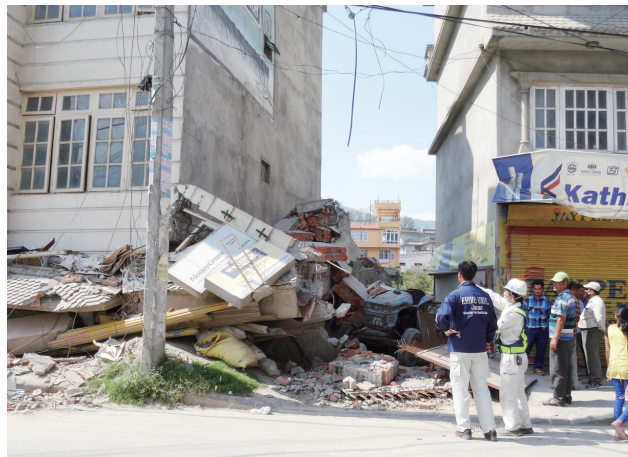
ネパール地震被害調査 (平成27年5月)
