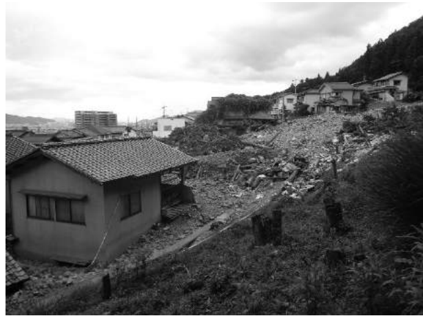
広島土砂災害現場
