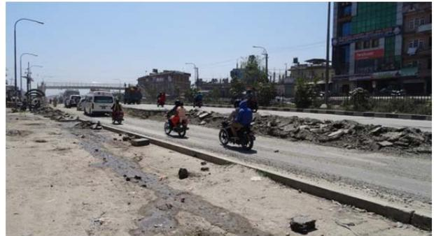
■カトマンズ→バクタプル方向の左車線が約1m沈下
