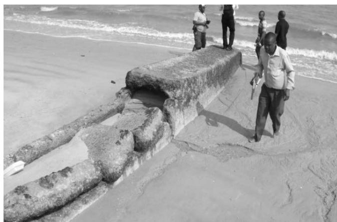
写真-3(a),(b) Beira 侵食海岸での部分的に崩壊した突堤とその測量調査
