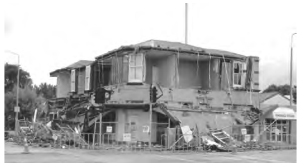
写真1 組石造2階建て商店兼住宅の被害
