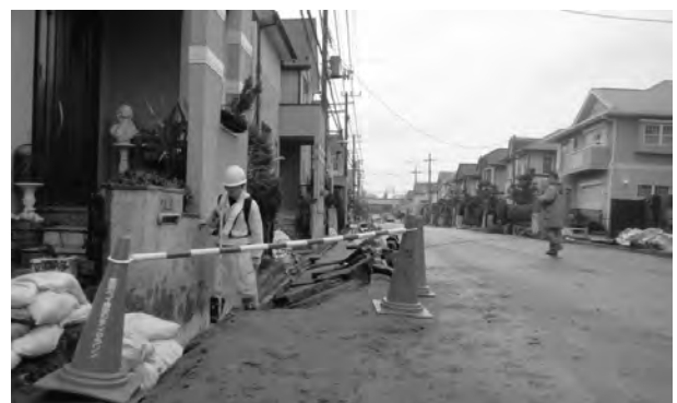
写真2 浦安市舞浜3住宅造成地での液状化
