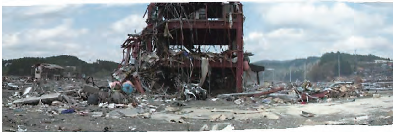
東日本大震災（南三陸町消防庁舎周辺）
