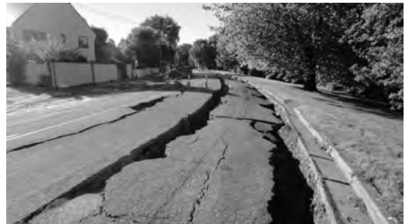
写真 4 エイボン川背後の住宅液状化被害
