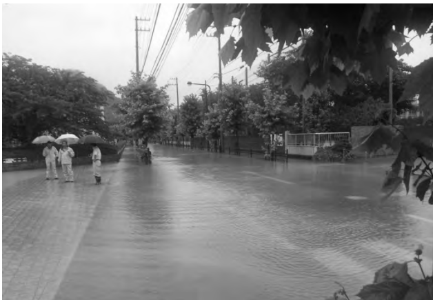
大雨で冠水した愛大正門前
