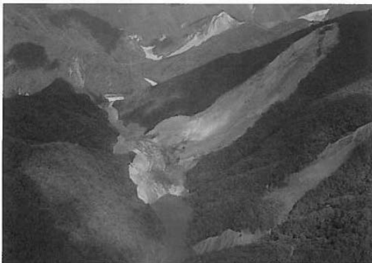
奈良県五條市大塔町赤谷地区の大規模土砂崩壊 (出典：近畿地方整備局HP)
