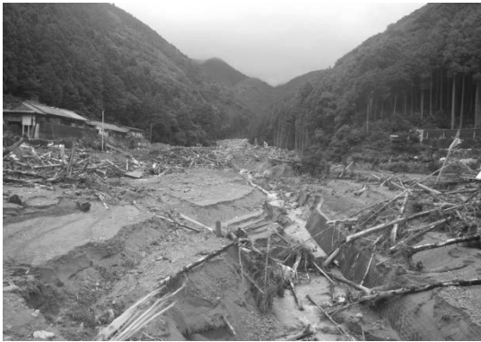
新宮川支川の被災状況
