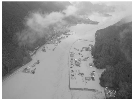
新宮川の支川の被災状況 (出典：紀南河川国道事務所HP)
