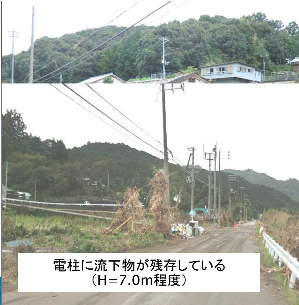
電柱に流下物が残存している
