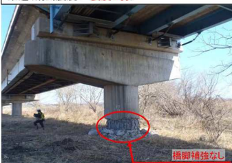
【耐震補強なし】 橋脚が地震動により損傷
