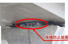
【耐震補強なし】 橋脚が地震動により損傷
