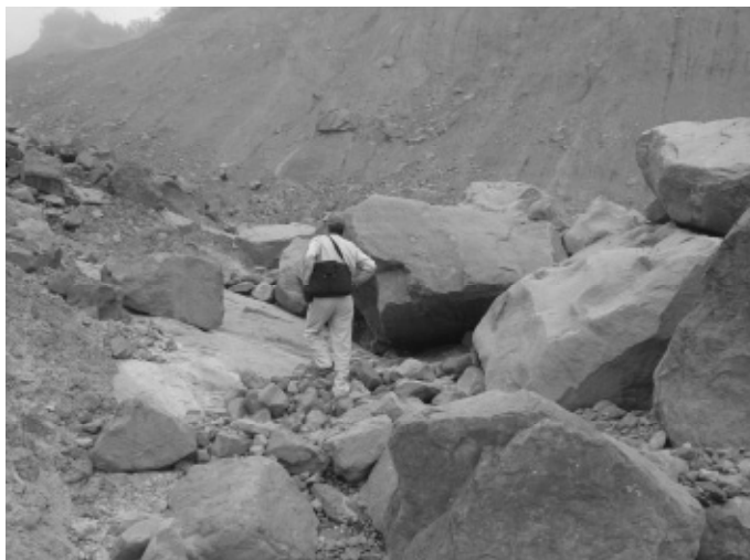
土石流により壊滅した小林村 (高雄県甲仙郡小林村)
