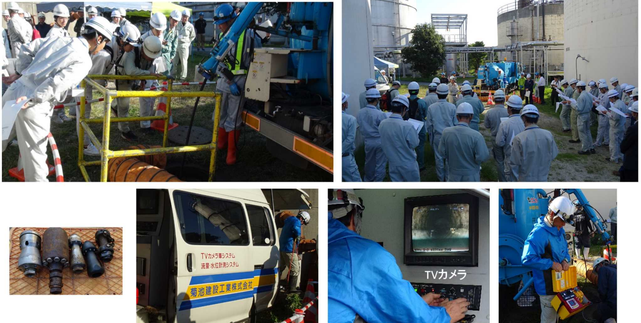
写真 3-5 フィールド実習（下水道）の状況
