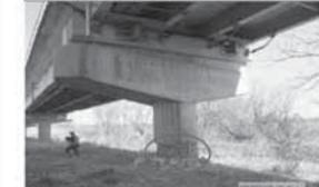
【耐震補強なし】 橋脚が地震動により損傷
