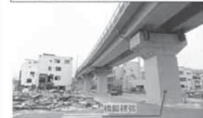
【耐震補強済(鋼板巻立補強) 地震動により損傷なし。】
