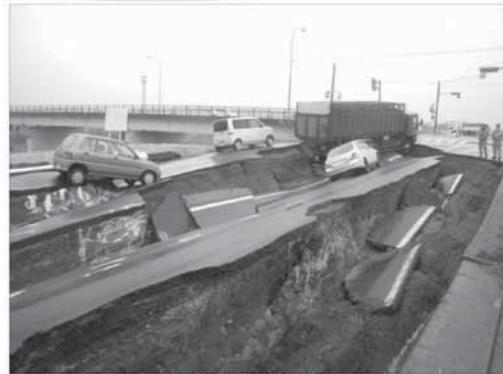
液状化により大破した北上川の堤防
