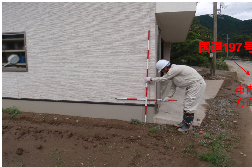
阿部板野地区 肱川右岸 家屋床下浸水 約50cm浸水
