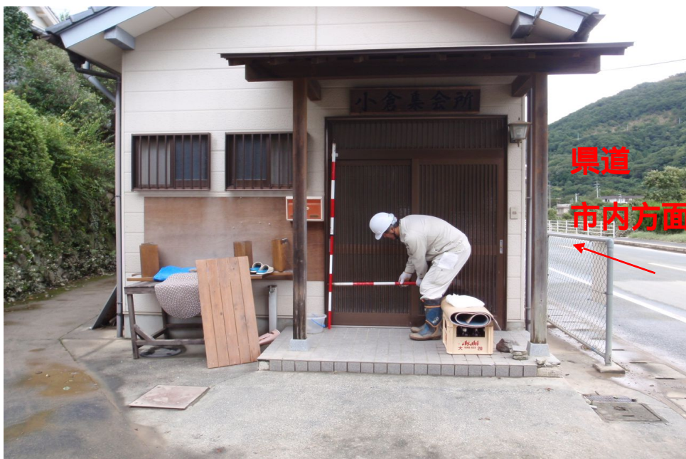
小倉地区 (肱川左岸) 県道大洲野村線沿い 床下浸水
