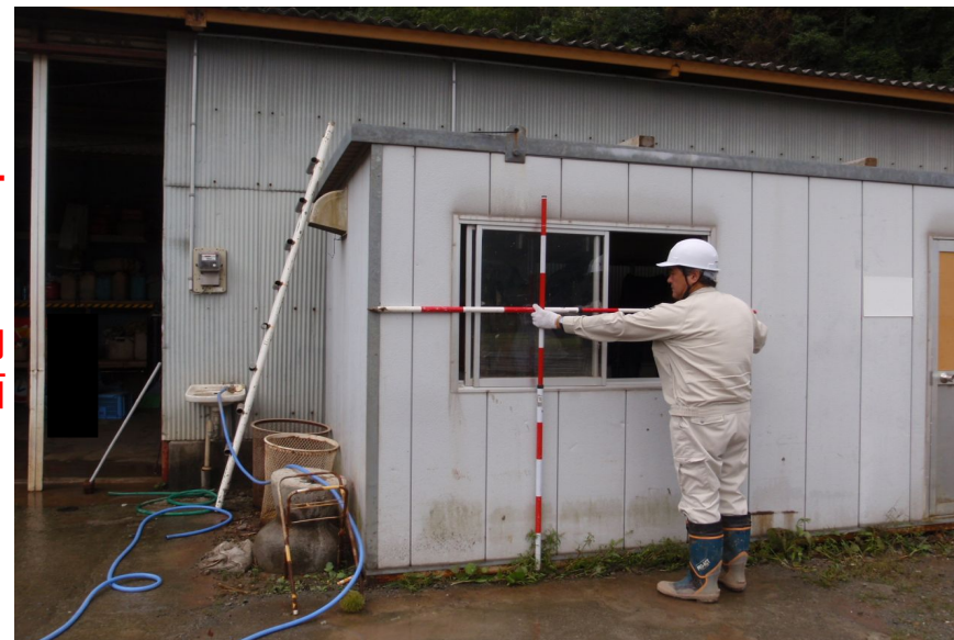
池田成見地区 肱川左岸 非住家床上浸水 約1.4m浸水
