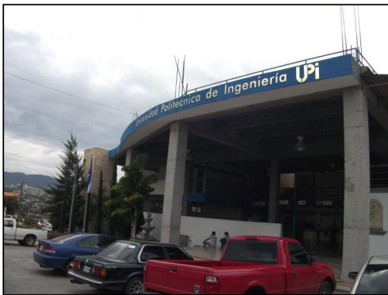
図 8 総合工科大学(UPI)の校舎。天井に鉄筋があり今後6階まで建て増しの計画あります。
