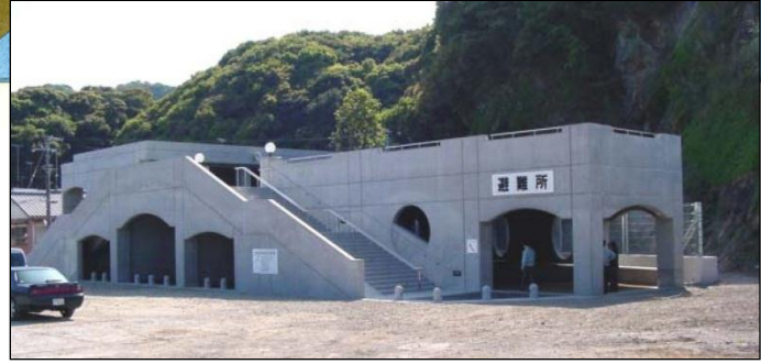
徳島県海陽町の津波避難ビル
