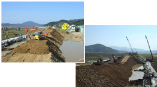
【災害現場で応急対策や復旧・復興に頑張る建設業界】
