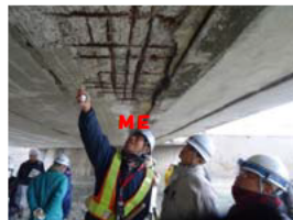
橋梁点検での点検手法のアドバイス
