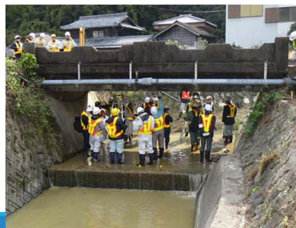
点検の実習(仕出橋)
