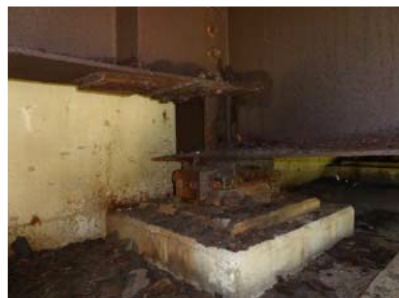
支承 (支承は塗装仕様)
