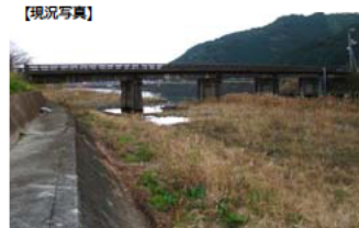
▲下ノ加江橋（供用から58年経過）
