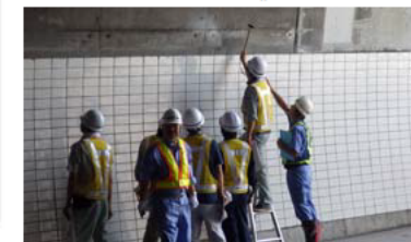
現地実習状況 (H28トンネル初級)
